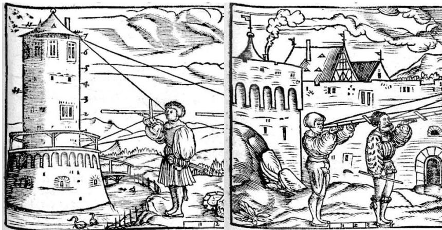
Abb.8: Messung der Turmhöhe mit dem Jakobsstab, Köbel 1535
